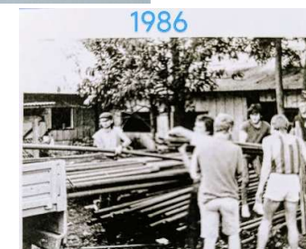
Die Teilnehmer der ersten Aufbau- gruppe laden Rohre für das Wasser- bauprojekt ab.
